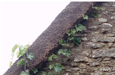
Vigne vierge s'introduisant dans la couverture : à couper
