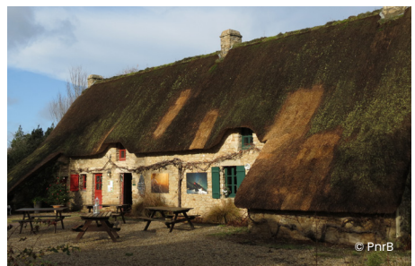
Les zones plus claires ont été reprises. Il s'agit principalement de zones sensibles : noues de lucarne, pentes de toit plus faibles, souche de cheminée...
