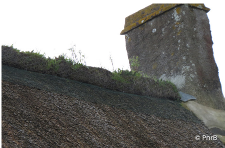
Un grillage a été posé sous le faitage pour limiter l'érosion, pouvant être accentuée par l'action d'oiseaux.
