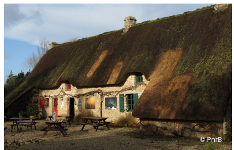
Un grillage a été posé sous le faitage pour limiter l'érosion, pouvant être accentuée par l'action d'oiseaux.
