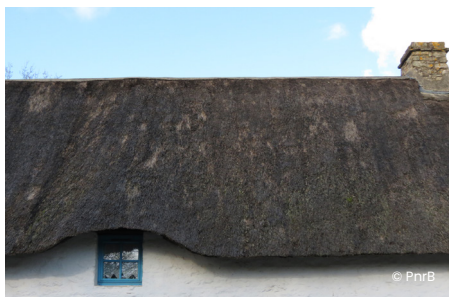
Décomposition par plaques de la toiture (zones plus claires)
