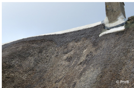
Décomposition par plaques de la toiture (zones plus claires)
