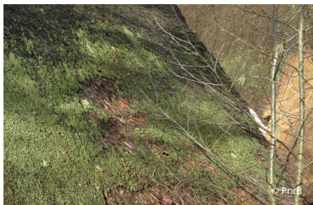
Branche frottant la couverture par contact direct, et la creusant
